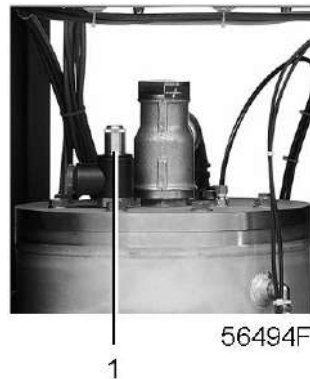
Предохранительный клапан
